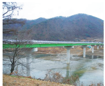
12. 포장 및 방호벽 설치(완성)
