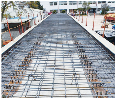
8. 바닥판 철근 가공조립
