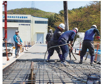
9. 바닥판 콘크리트 타설
